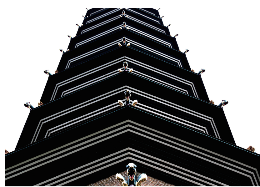
这是3月27日在英国伦敦邱园(英国皇家植物园)拍摄的中式宝塔。邱园宝塔由英王乔治三世的建筑师威廉·钱伯斯设计,1762年竣工。这座八角形塔塔共有10层,高约50米。邱园宝塔被认为仿照南京大报恩塔建造,而且这两座皇家宝塔都是当时中英两国最高的建筑。
