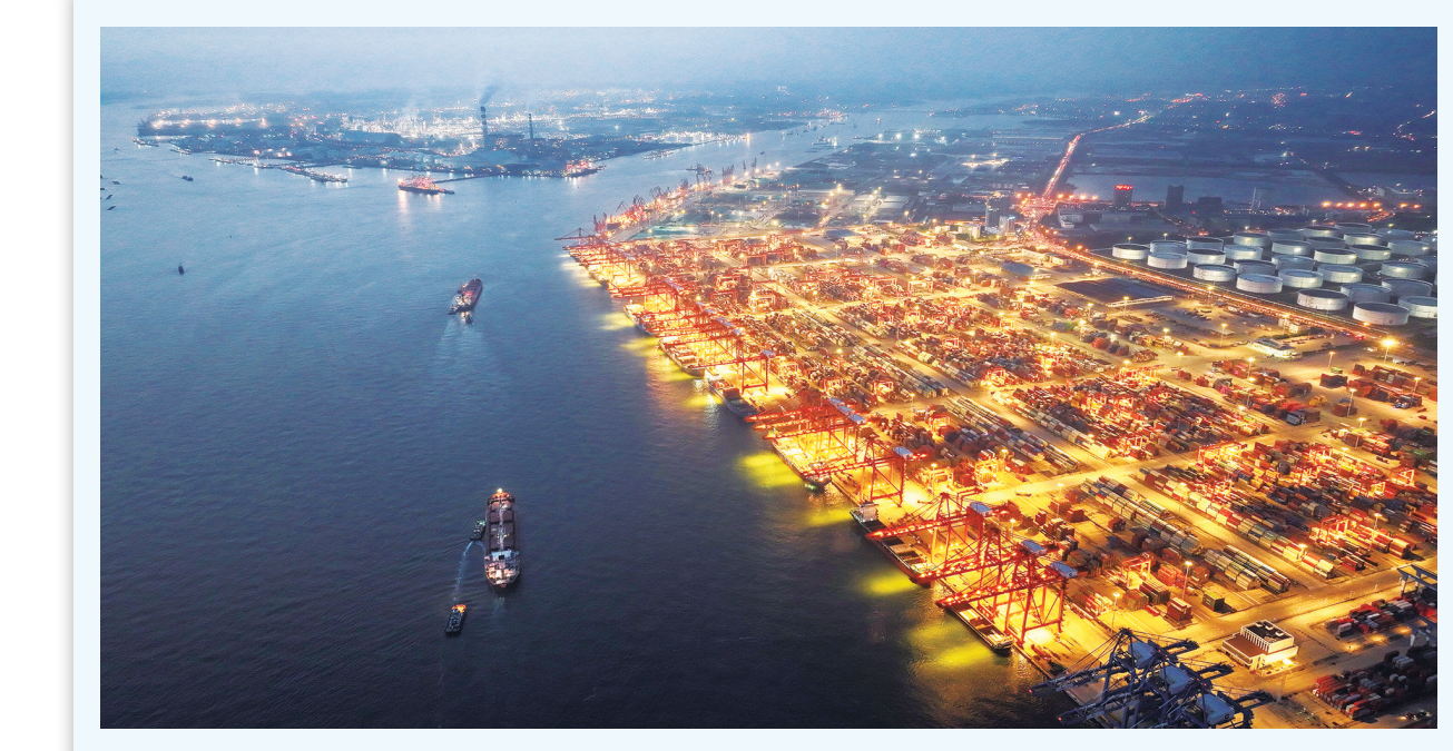
近年来，广西以高水平共建西部陆海新通道为牵引，建设面向东盟的国际大通道、大平台，加快打造向海经济，推动构建陆海相通、多区联动的开放格局。图为夜幕下的广西钦州港码头(5月9日摄，无人机照片)。 新华社记者 张爱林 摄
