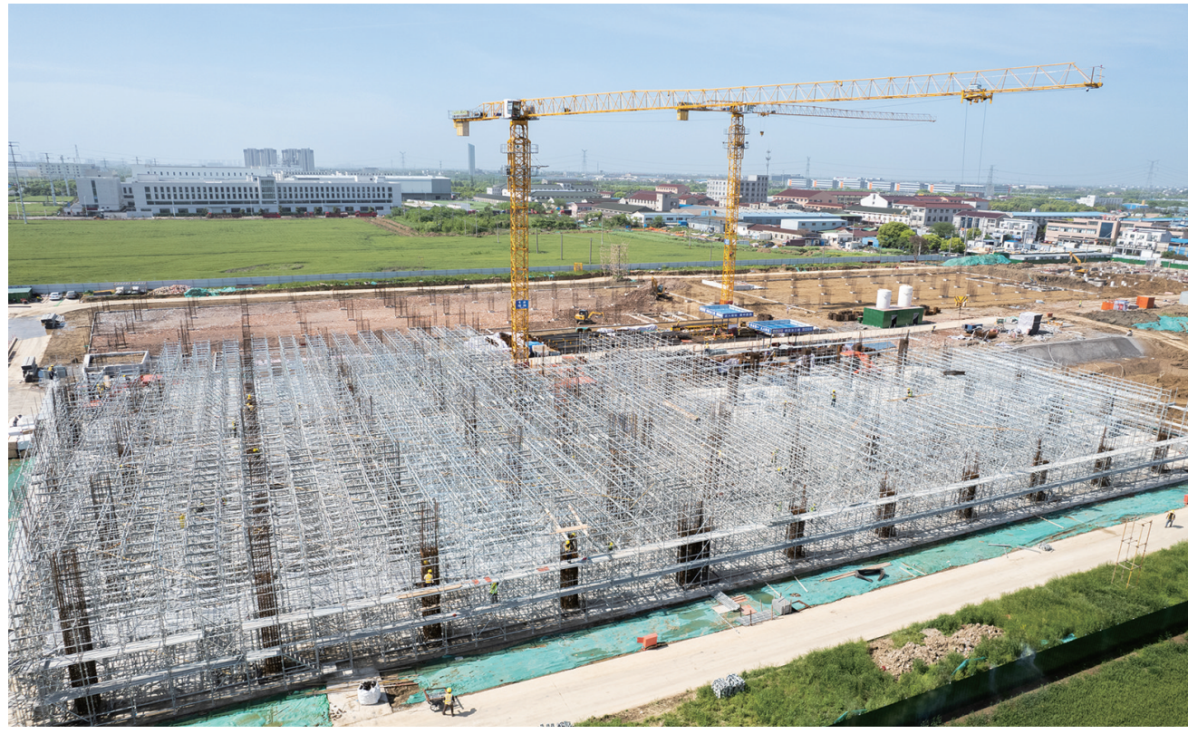
常州恩都法新能源汽车热管理系统项目正在建设中。
