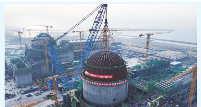
6月18日拍摄的徐大堡核电站4号机组穹顶吊装作业现场(无人机照片)。当日,位于辽宁省葫芦岛市的徐大堡核电站4号机组顺利实现穹顶吊装就位,为进一步推进工程建设奠定基础。
