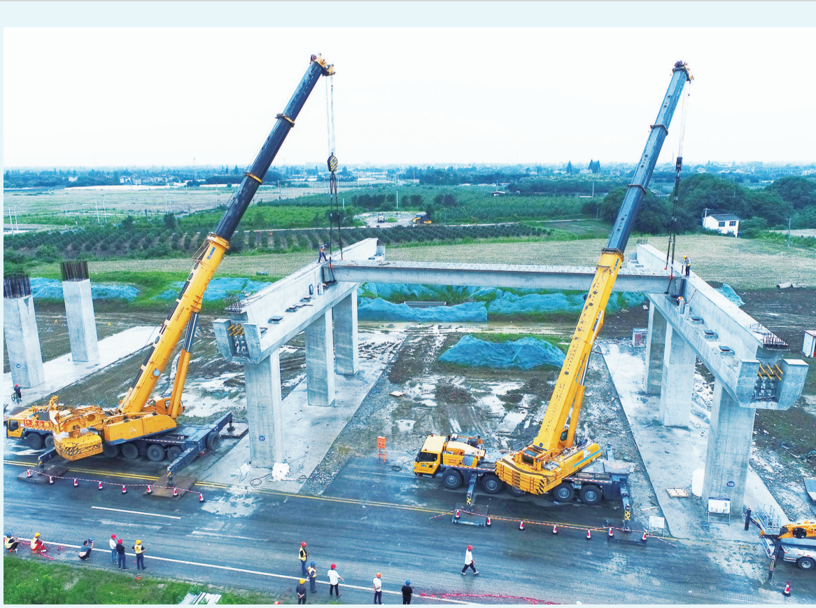
6月29日上午，腾龙大道智慧快速路二期工程首件预制箱梁顺利完成架设，标志着该项目主线高架桥上部结构施工正式拉开帷幕。
