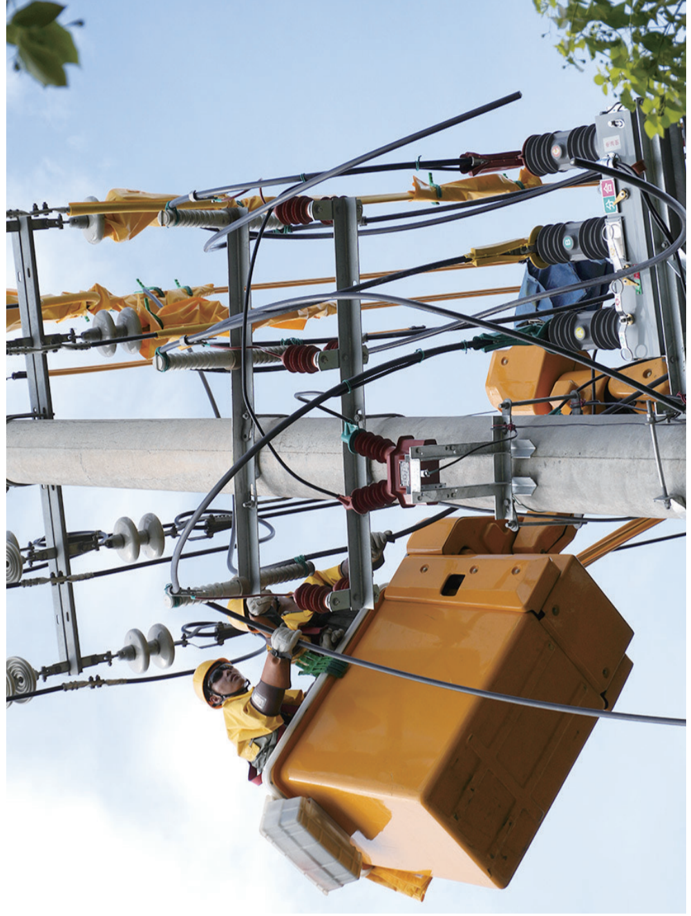
电力工人在金坛区长湖路进行带电作业施工,确保沿线用户用电“零影响”。
