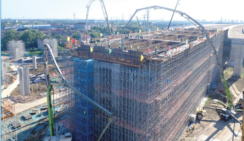
本报讯(李焱 黄洁璐 刘路)7月29日上午,历经16小时的连续奋战,G312快速路工程项目现浇箱梁首件圆满完成浇筑,为全线桥梁上部结构施工按下加速键。
