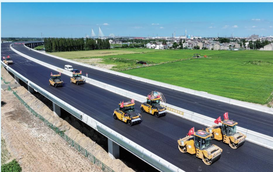
在常泰长江大桥南接线项目施工现场,无人驾驶的摊铺机、压路机组成的集群装备正在开展沥青摊铺施工。这是全省首次在新建高速公路沥青中面层施工中大面积运用数字化施工技术。
