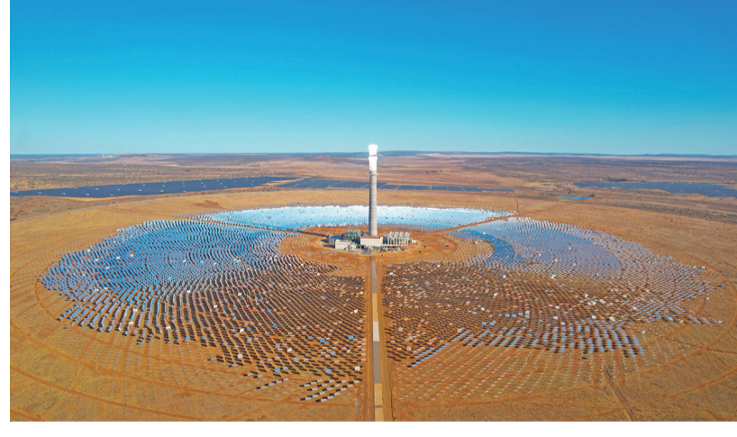
这是8月25日在南非北开普省拍摄的南非红石100兆瓦塔式熔盐光热电站项目(无人机照片)。
