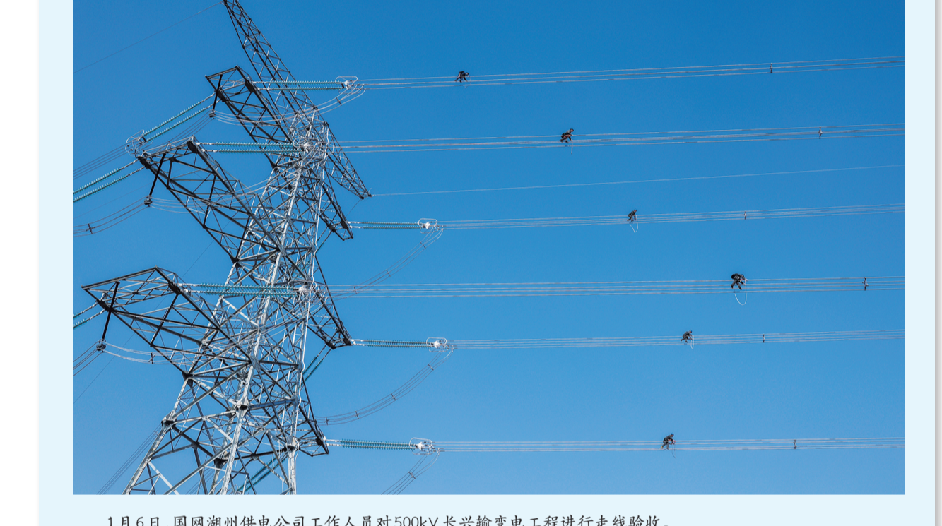
1月6日,国网湖州供电公司工作人员对500kV长兴输变电工程进行走线验收。位于浙江省湖州市的500kV长兴输变电工程预计年供电量可达70亿千瓦时,将于1月下旬正式投运,进一步打通江浙电力能源大通道,提升浙北片区供电能力,保障当地不断增长的用电需求。新华社发
