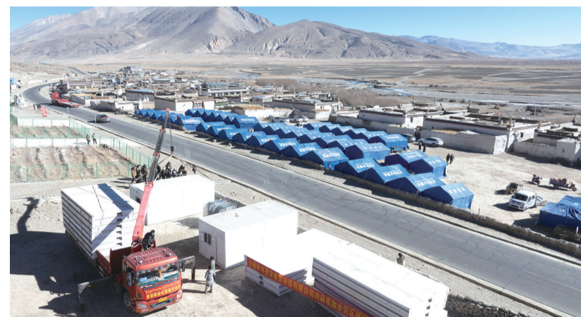
这是1月11日拍摄的白拉村板房建设现场(无人机照片)。当日，在西藏萨迦县麻布加乡白拉村，工程人员与有相应技术的村民一起建设活动板房。据了解，这是萨迦县地震灾区开建的第一批板房。新华社发
