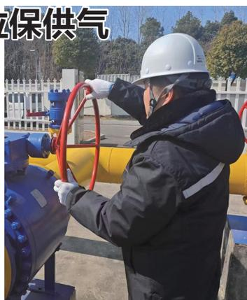
港华工作人员还陆续执行了清管、检测等工序,全面开展高压燃气管道检测,保障春节期间及节后客户复工复产的供气需求。
