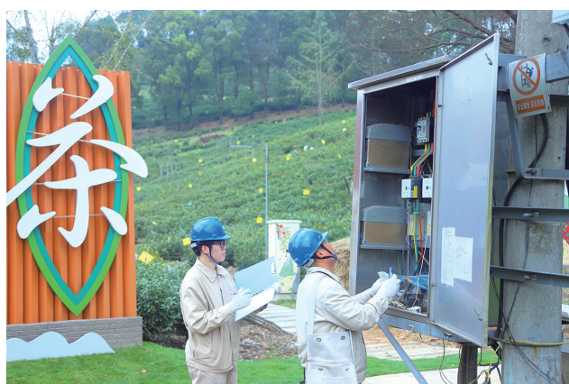
供电党员服务队为茶场进行特巡
