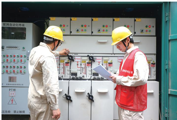
常州供电城区供电服务中心四级职员苏华介绍,以前需要工作人员到现场使用超声波局部放电检测仪,通过耳机去听,靠经验判断。应用AI“声纹”在线监测技术后,只要在保电期间把“声纹”感知装置吸附在设备上,就能做到24小时自动“巡
