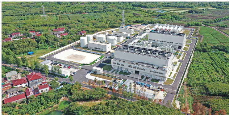
被誉为“超级充电宝”的金坛盐穴压缩空气储能国家试验示范项目
