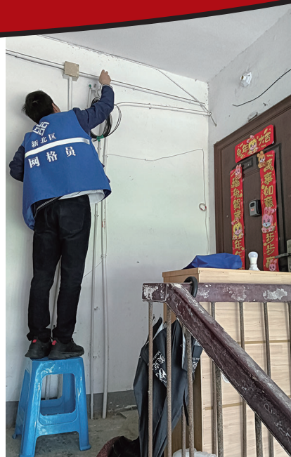
赵天祥在更换楼道内灯泡
