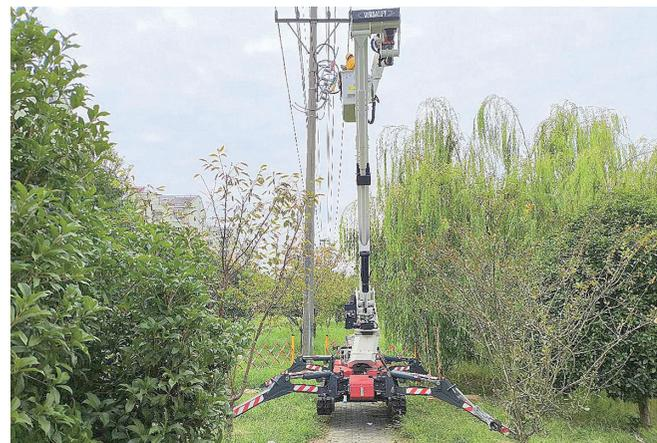
本报讯(项大卫 彭迪 秋 图文报道)在溧阳市南渡镇10千伏伏丰113线施工现场,一台造型奇特的“蜘蛛车”在带电作业人员的操控下,缓缓驶入树丛中,开展新装刀闸高压引线施工。这是国网溧阳市供电公司首次运用履带式绝缘斗臂车开展带电作业。
