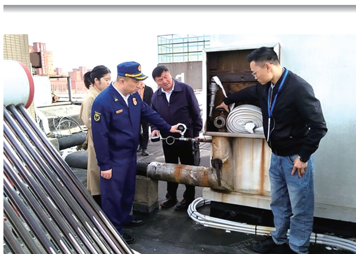
武进区对高层住宅智慧消防项目竣工验收
