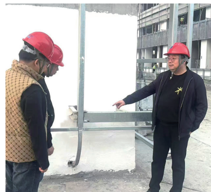
杨高在检查施工质量
