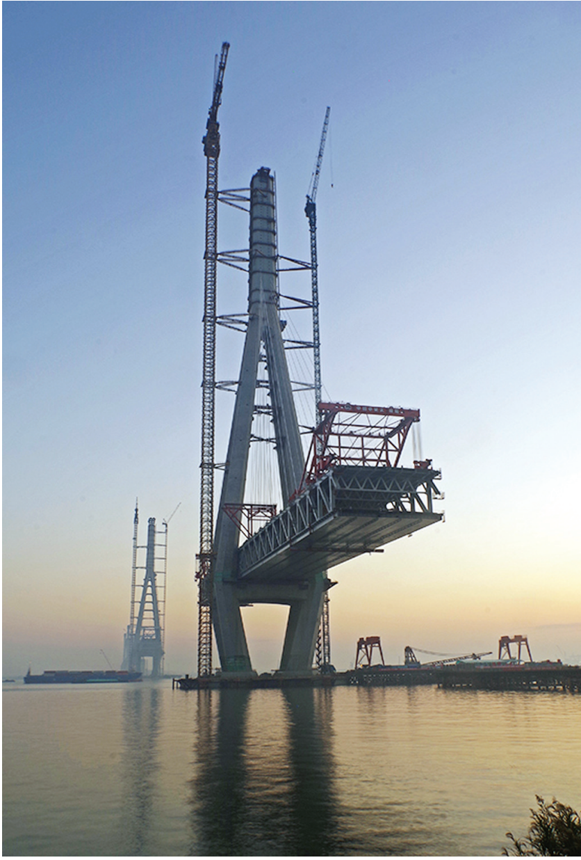
常泰大桥 兰陵村野 摄
