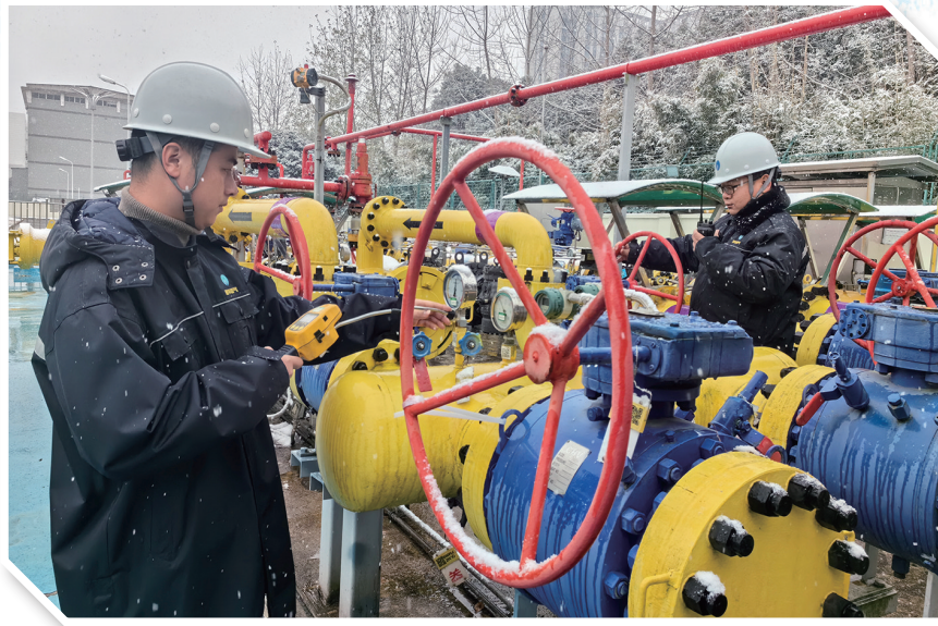
港华燃气员工正在巡检天然气门站设施。朱玲云摄
