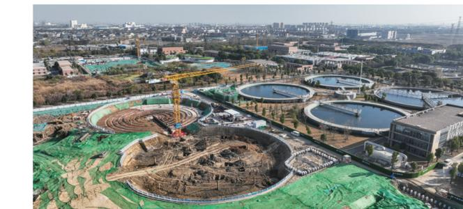
本报讯(郑雨露 王锐 杨宽)记者15日从市排水管理处了解到,我市江边污水处理厂五期及污水资源化利用工程(以下简称“江边污水五期工程”)有了新进展,工程中最大单体生物反应池的桩基及基坑支护结构已完成施工,进入土方开挖阶段。
