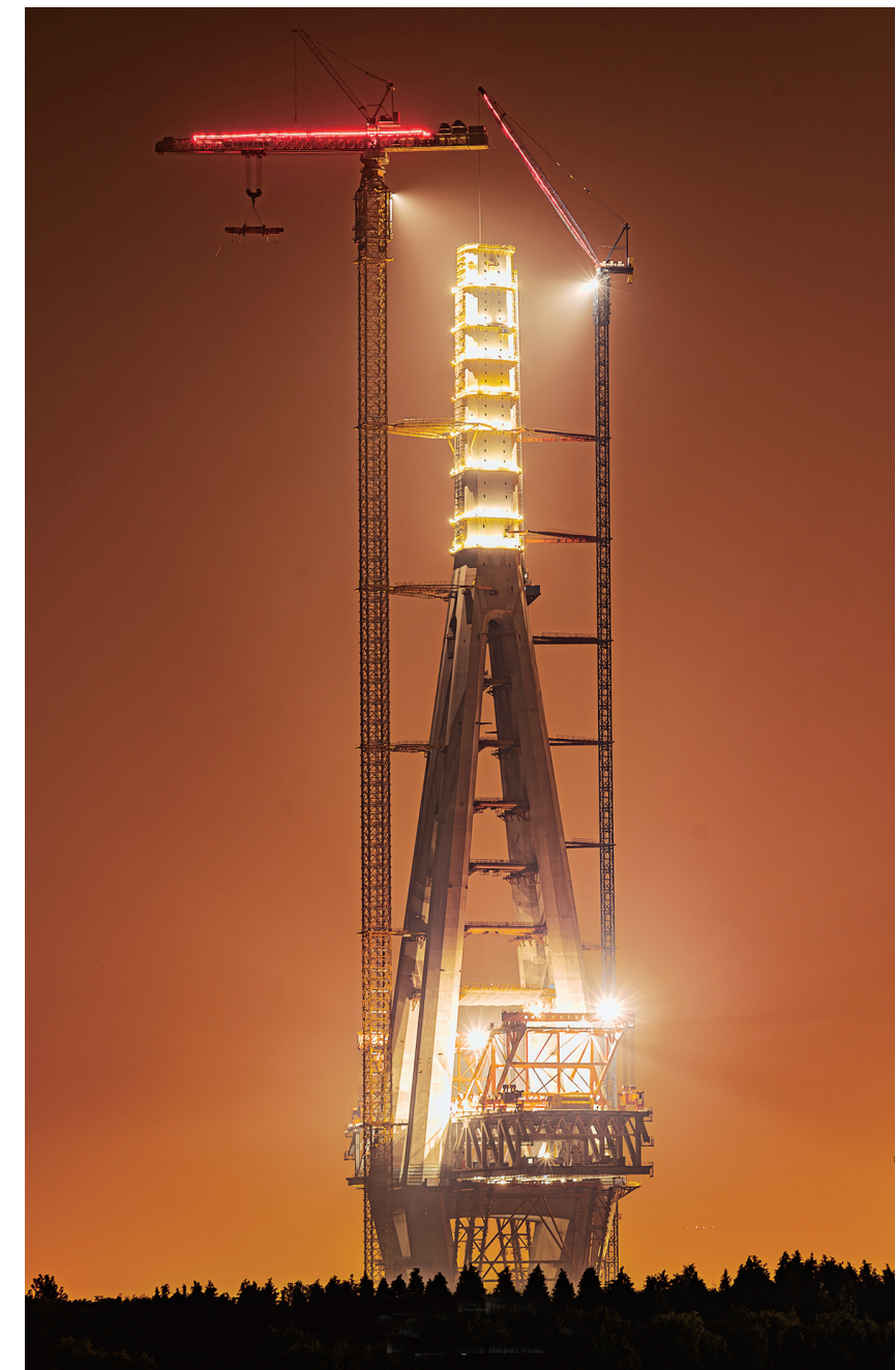
常泰大桥 墨天0822 摄
