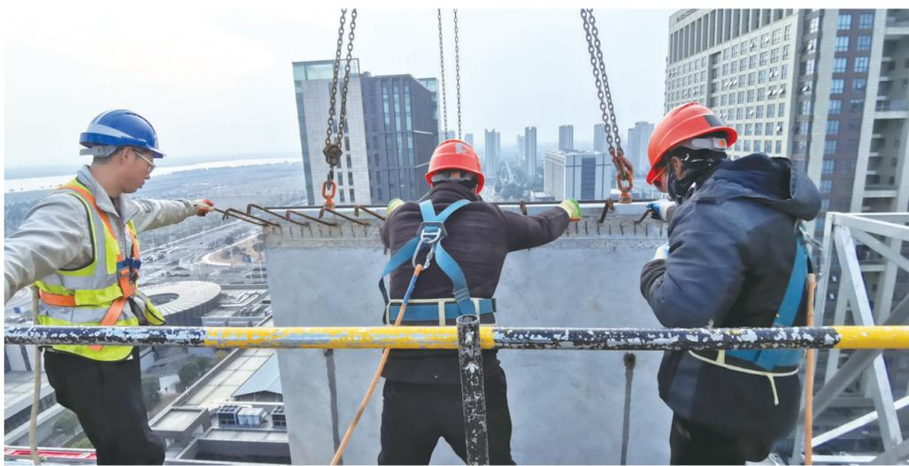
经理丁春花介绍,江南金科大厦建筑面积4万平方米,其中地上19层共3万平方米,所有结构主体构件包括柱、梁、墙、板、楼梯都是混凝土预制构件,均在工厂生产制作完成,且每个构件上都有二维码,通过扫描二维码就可以查看到构件的安装位置、编码、重量、尺寸等详细信息,整个施工过程可以用“搭积木”来形容。
