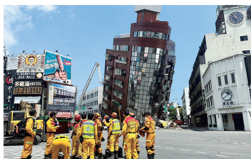
在花莲市，地震造成一栋大楼严重倾斜（4月3日摄）。新华社发
