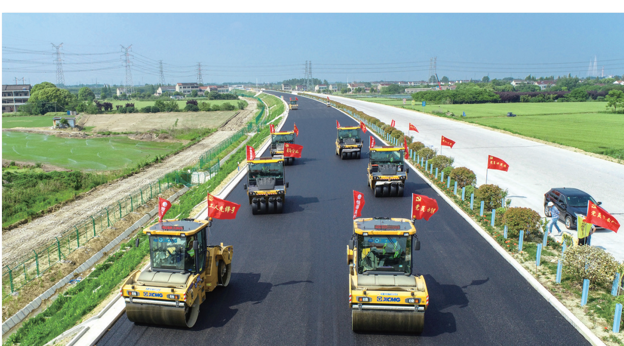
5月8日,记者在常泰长江大桥南接线项目主线看到,1台大型摊铺机正将滚烫的沥青均匀摊铺在道路上,7台压路机紧随其后,来回有序碾轧平整。当天起,南接线正式进入大面积沥青摊铺阶段。
