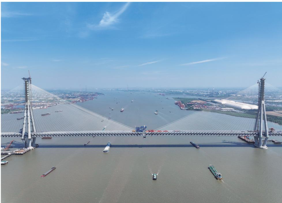
主航道桥最后一节钢桁梁吊装到位
