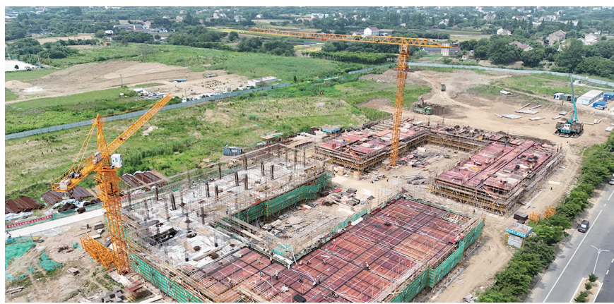
新校区建设现场
