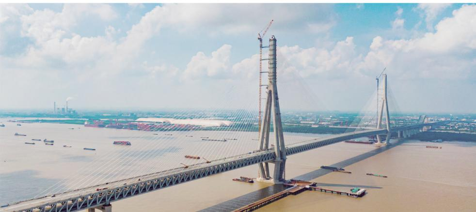
大桥水平拉索单根由127丝直径7毫米的碳纤维复合材料组成，为目前世界上碳纤维拉索长度最长、规模化用
