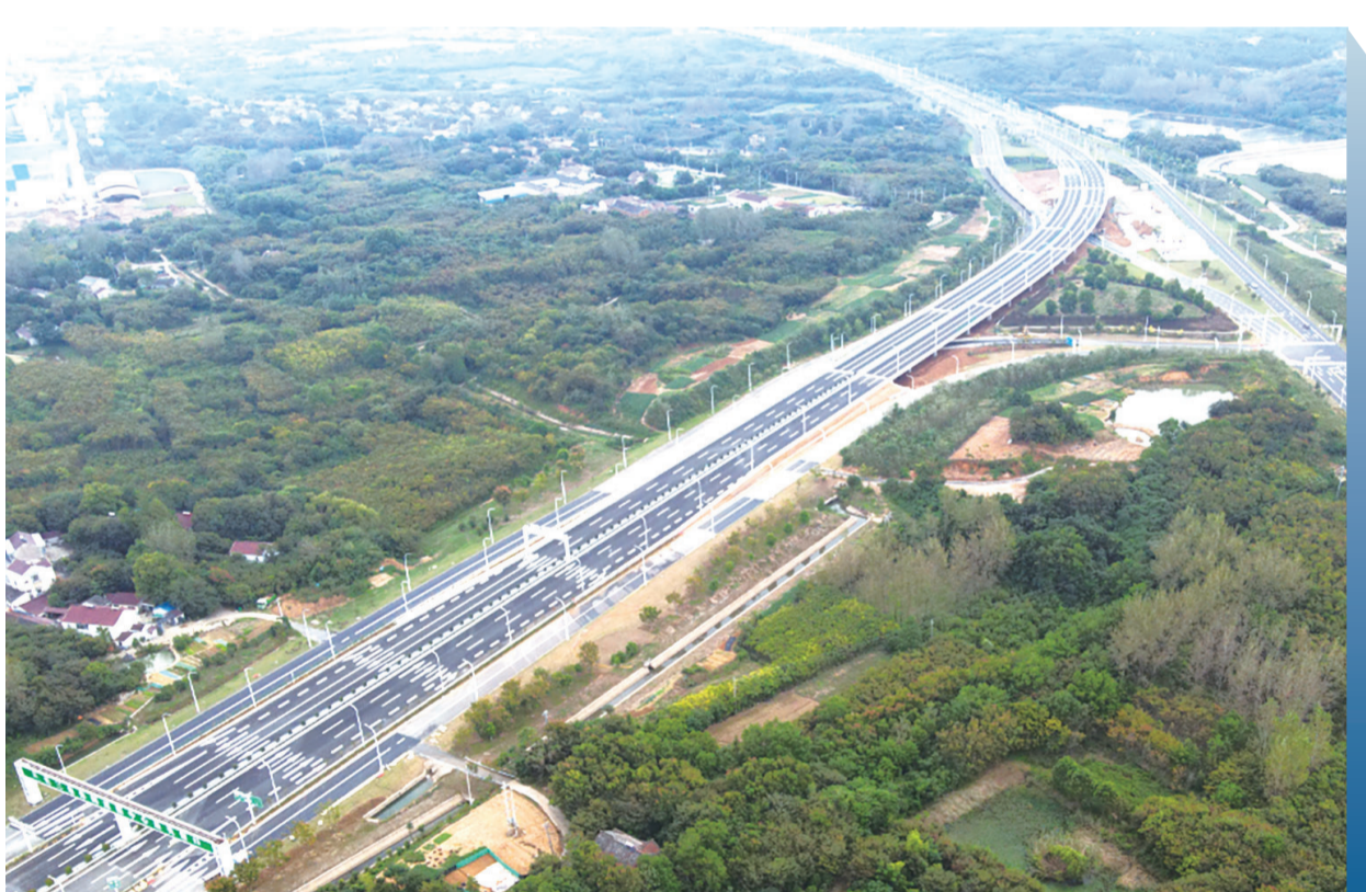
9月26日，金坛茅山旅游大道寻仙路互通大桥正式通车。项目全长约0.8千米，其中新建大桥1座，长度400米，总投资约1.37亿元。该项目是连接金坛主城区与茅山旅游度假区的关键纽带，实现了金坛主城区与茅山旅游度假区全程快速化，将有力促进金坛茅山片区乡村振兴和城乡融合发展。 杨成武 夏晨希图文报道
