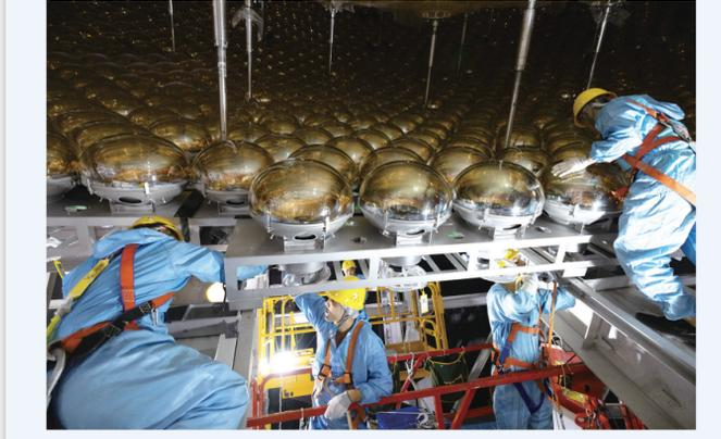
10月9日,工人在安装中心探测器上的光电倍增管。新华社发
