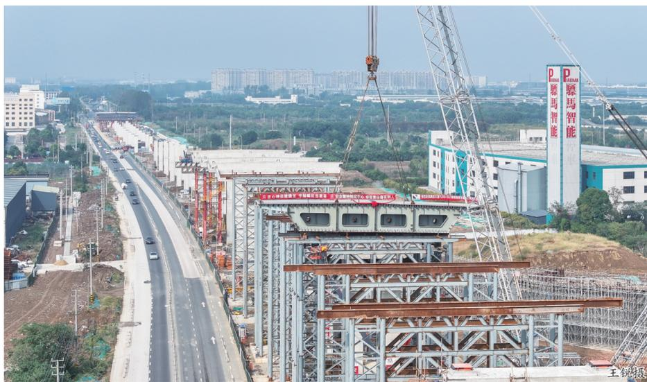
本报讯（黄洁璐 常路轩 张磊）10月28日上午，腾龙大道智慧快速路二期工程（以下简称腾龙大道）首件钢箱梁顺利吊装，标志着该项目主体结构施工进入加速期。当天，该项目4标段、7标段同时开展钢箱梁吊装作业，形成各标段间的你追我赶之势。其中，7标段吊装的钢箱梁为腾龙大道项目龙城大道枢纽主桥部分。龙城大道枢纽是腾龙大道的控制性节点工程，是我市首个全直连式高架枢纽。直连式枢纽不设置环圈匝道，用高度换占地，采用五层枢纽，顶层标高44.3米，距离地面37.6米，比常见的苜蓿叶式、涡轮式枢纽可节约30%—40%的用地，减少15%—20%的桥梁规模。该枢纽转向匝道设计速度不低于50公里/小时，有较高的通行能力和交通转换效率。当天吊装的钢箱梁安装高度超25米，位于该枢纽第四层主桥，为5
