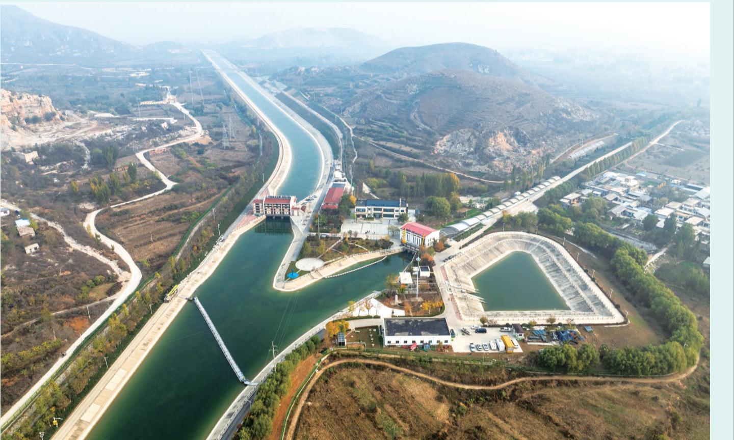
这是11月8日在保定市拍摄南水北调中线一期工程的西黑山节制闸工程(无人机照片)。 新华社发
