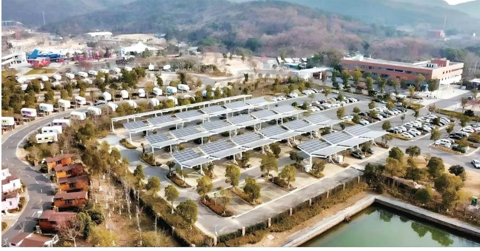
1月8日,太湖湾露营地新增的“光储能”一体化停车场开始运行,规划建设约2400平方米屋顶光伏,预计年发电量可达50万度,以切实解决新能源车主出行电量不足的烦恼,让绿色“微度假”出行体验感直接拉满。
