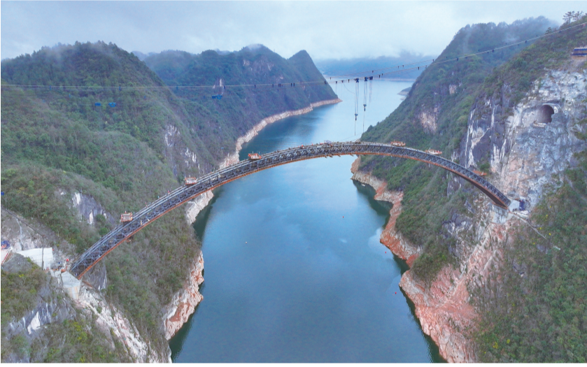
这是合龙后的乌江特大桥(3月5日摄,无人机照片)。 3月5日,贵州瓮马铁路南北延伸线项目控制性工程乌江特大桥顺利合龙。乌江特大桥全桥长约520米,主跨337米,桥面至江面高度约200米。瓮马铁路南北延伸线北起瓮安延伸至遵义,南起马场坪延伸至都匀,全长148公里。 新华社发
