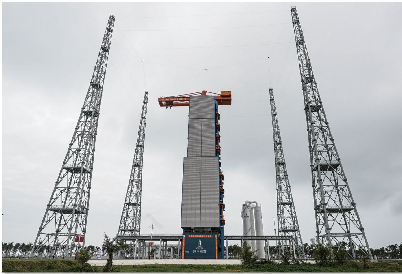
3月11日在海南文昌拍摄的海南商业航天发射场一号发射工位。
