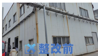
利来再生物资有限公司整改前
