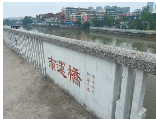
处在运河和南运河交汇处的南运桥
